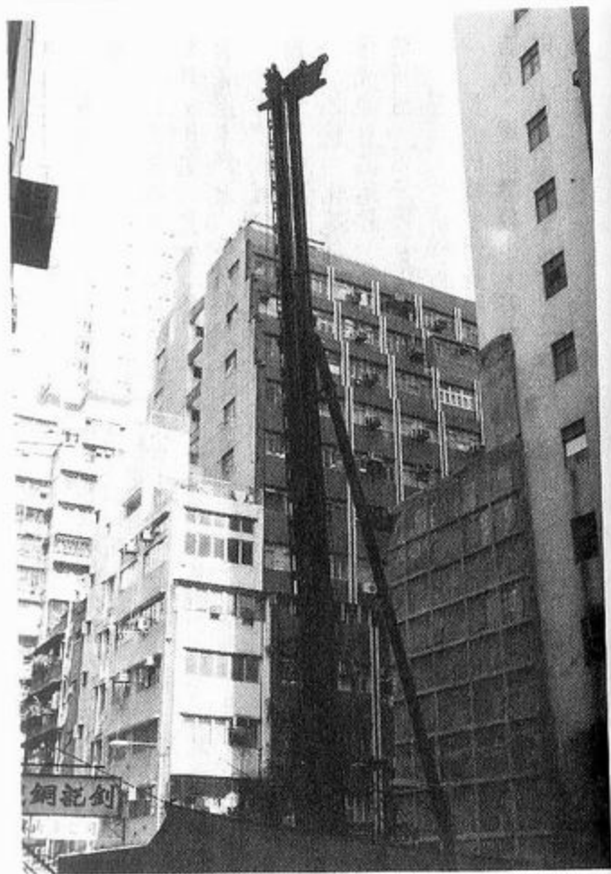
大廈外的地盤打樁，會令大廈犯聲煞。
