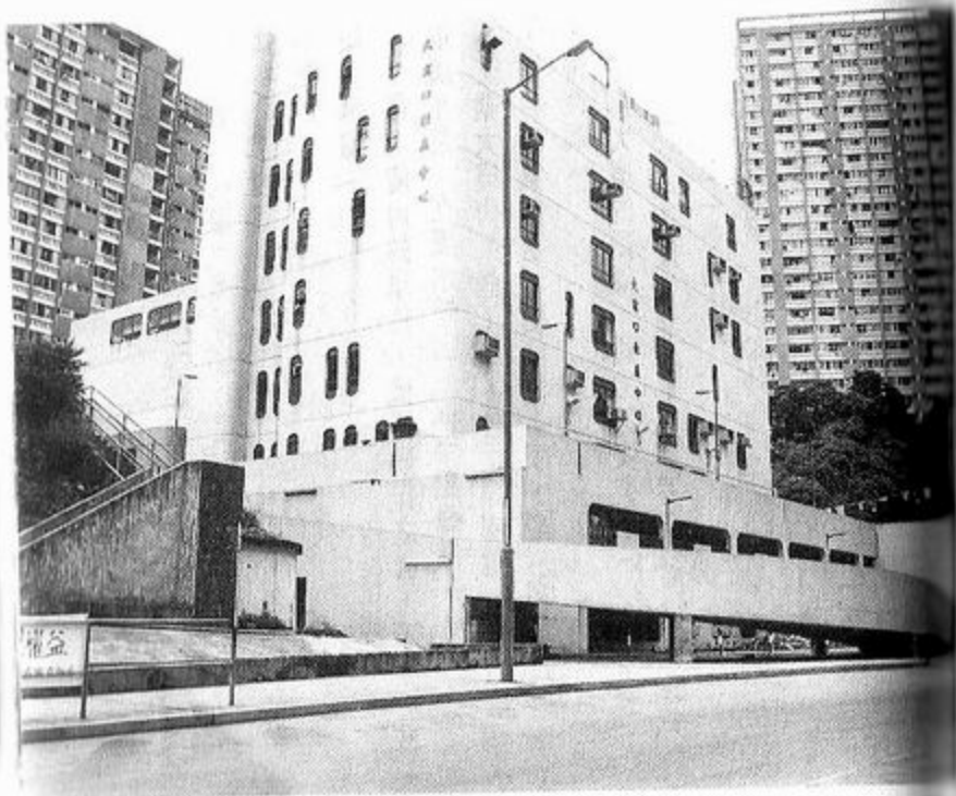
圖中六層高的建築物便是社區中心，左方的大廈很接近這中心。日間陽氣仍強，由黃昏開始，靜待陰氣凝聚。
