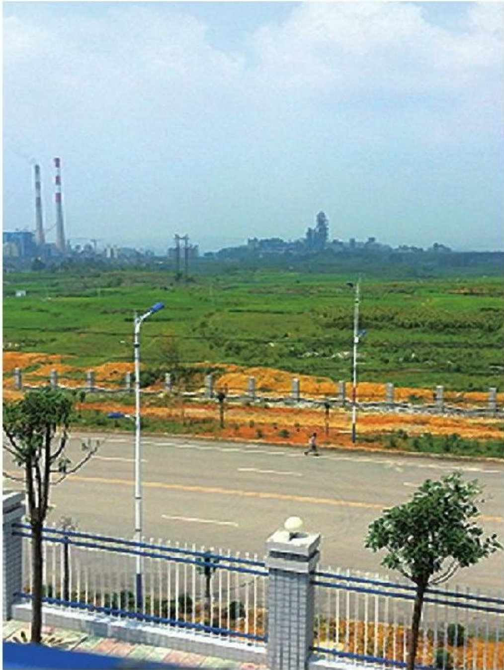
图5 西部某山区一处建有六车道的工业园
